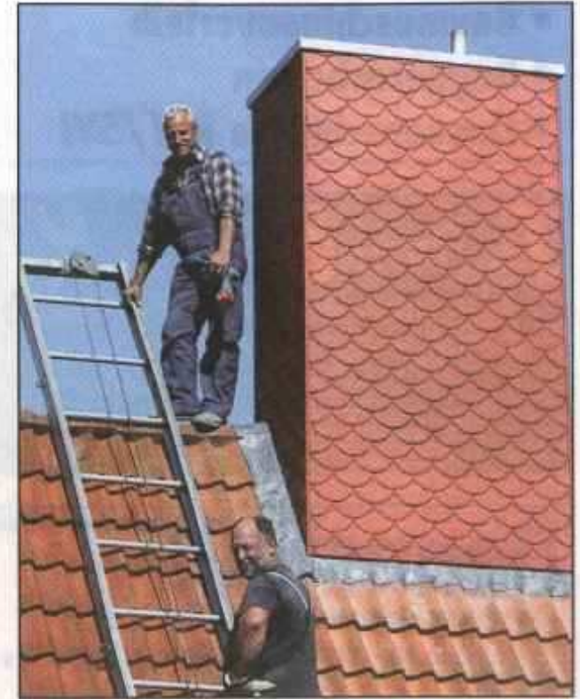
Nach Montage des Stülpkopfes hoch oben auf dem Dachfirst, Inhaber Joachim Clasen
